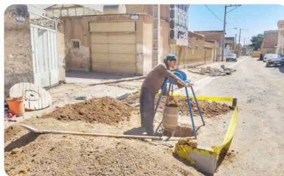
عملیات حفر چاه جذبی جهت هدایت آب‌های سطحی بلوار امام خمینی (ره)، کوچه شهید محسن جعفری
